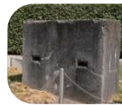
明治27年(1894)に、横浜港の防堤基礎として製造されたコンクリートブロック
